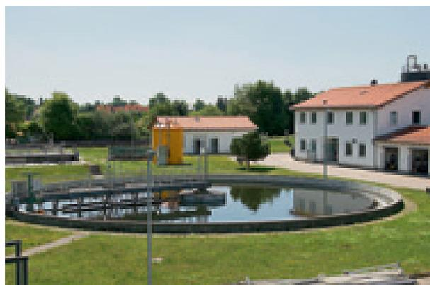
Fließgeschwindigkeit reduziert, dass Sand sich aus dem Abwasser trennen kann. Nach einer Messstrecke in der ph-Wert, Temperatur und Durchfluss kontinuierlich ermittelt werden, fließt das Abwasser in das Vorklärbecken. Dort setzt sich der anfallende Schlamm ab und wird als Primärschlamm dem Faulturm zugegeben.
